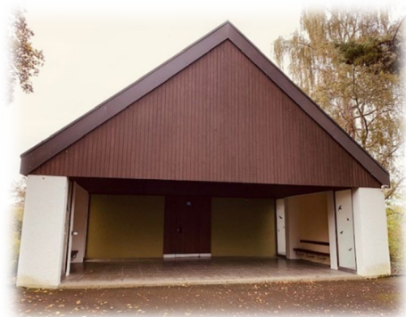
Friedhofsgebäude aktueller Zustand Juni 2024 vor der Sanierung
